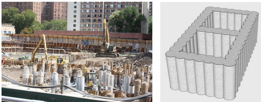
Figure 1. A gauche. Sols structurés constitués de pieux et micropieux (Brûlé et al. , 2015).
