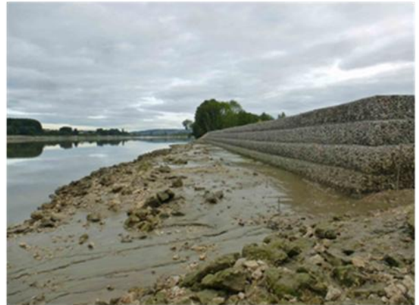
Mur en gabions terminé
