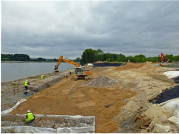
Construction du mur de gabions
