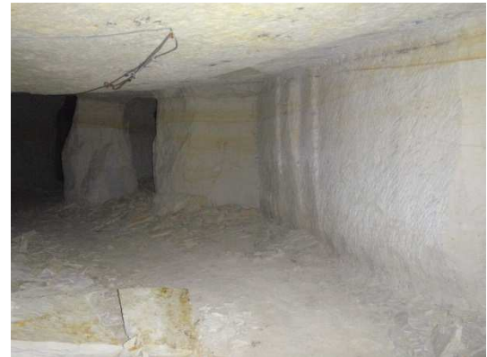
Figure 1 : détail d'une galerie de la carrière souterraine
