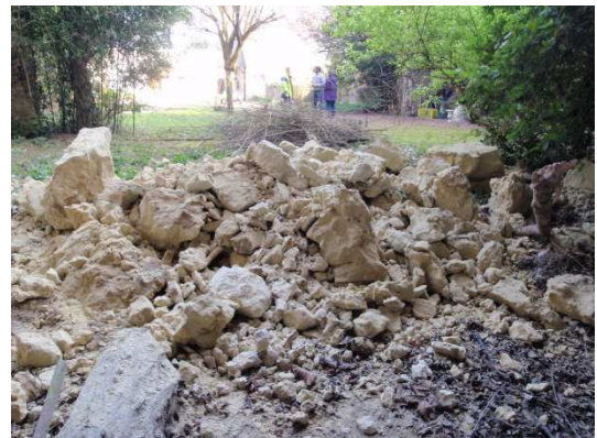
Figure 6 : détail des éboulis en pied du coteau à la suite de l'évènement de janvier 2014
