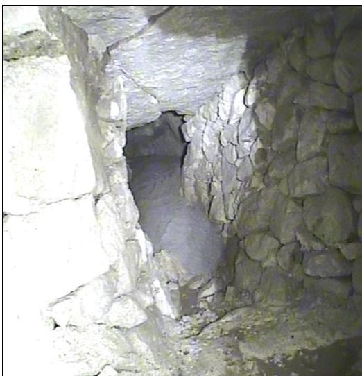
Figures 7 et 8. Carrière souterraine – Fractures du toit
