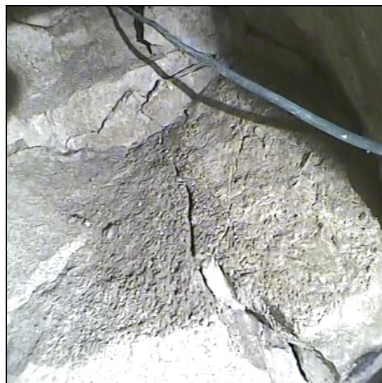
Figures 7 et 8. Carrière souterraine – Fractures du toit
