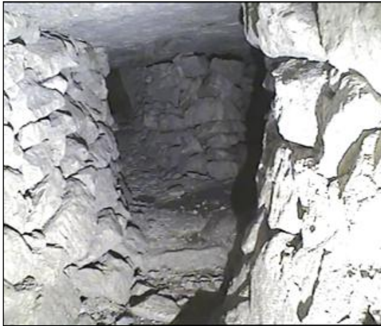
Figure 1. Carrière souterraine sous la ligne de Tramway.
