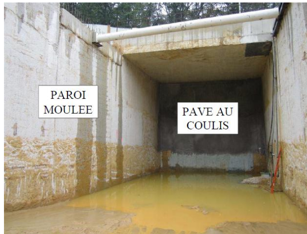
Figure 5. Vue de l'intérieur du puits d'entrée.
