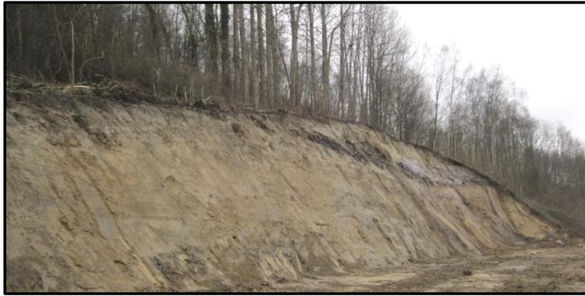
Figure 9. Vue des pré-terrassements, février 2016
