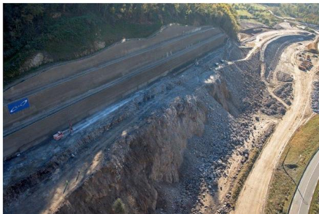
Figure 6. 3000 000 m<sup>3</sup> de déblai rocheux dont 230 000 m<sup>3</sup> de minage (photo L Tavares)
