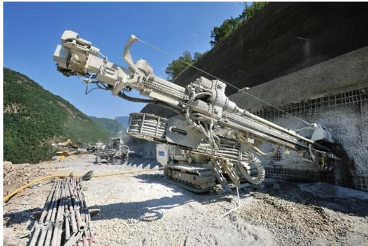
Figure 10. 18 000 m<sup>2</sup> de paroi clouée (photo V Ramet)
