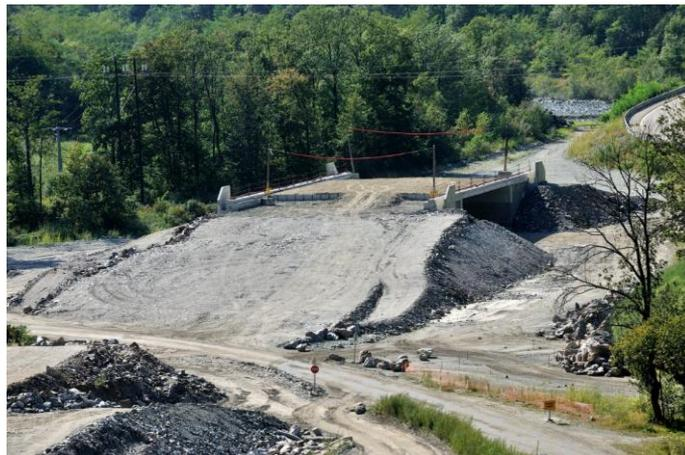
Figure 3. Ouvrage hydraulique qui relie le nouveau tracé à l'ancien (photo V Ramet)
