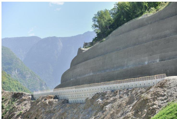
Figure 9. La PAROI AD/OC<sup>®</sup> en écailles béton préfabriquées (photo V Ramet)
