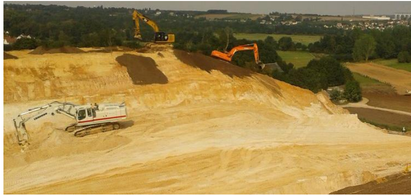
Figure 5. Travaux de terrassement dans les Sables de Fontainebleau.
