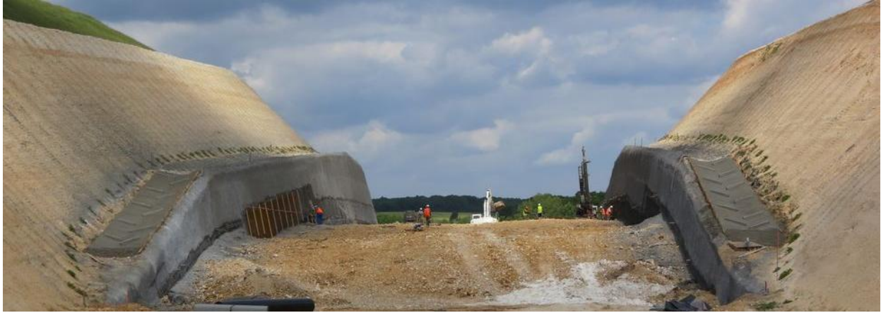
Figure 9. Vue des travaux de réalisation de la paroi clouée.
