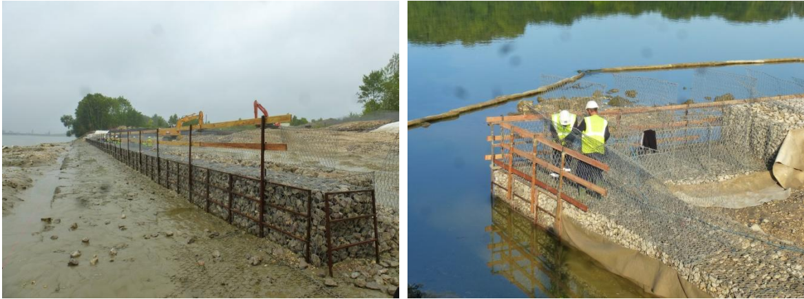
Figure 3. Mise en place du mur poids en gabions
