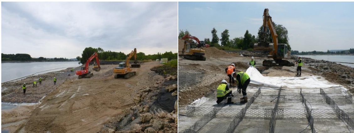
Figure 2. Terrassement de la plage et mise en place des matelas « Reno »
