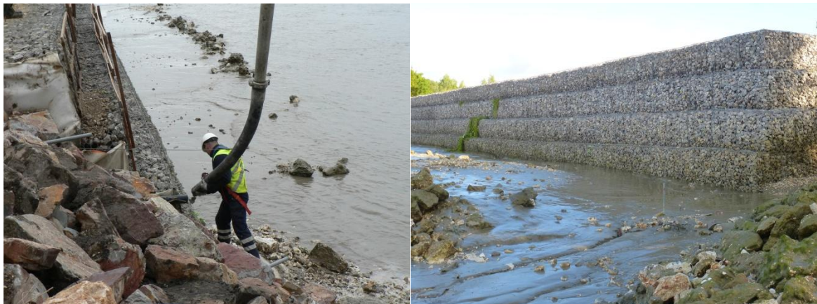
Figure 4. Mise en place des enrochements percolés et vue des travaux terminés
