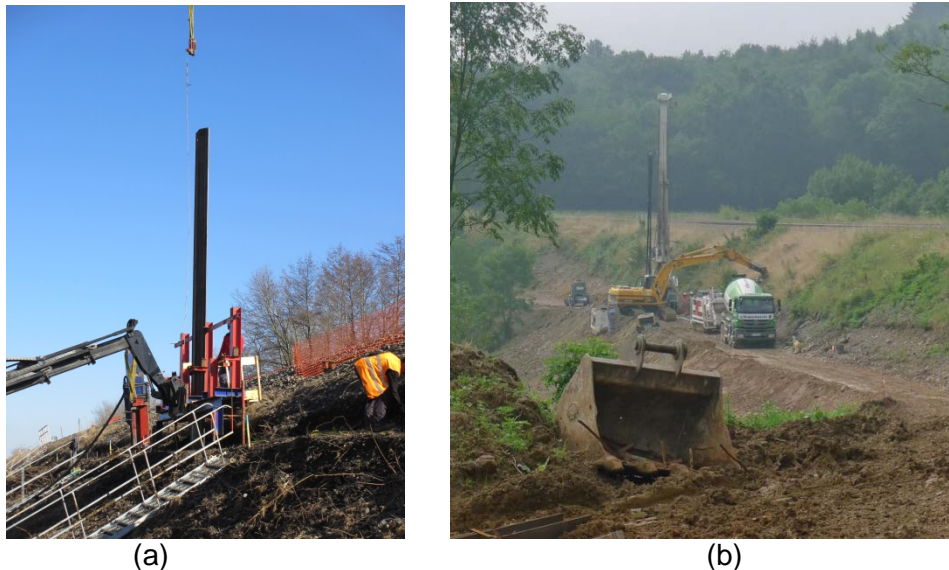
Figure 2 : Exemples de clouage vertical par pieux battus (a), pieux forés (b)
