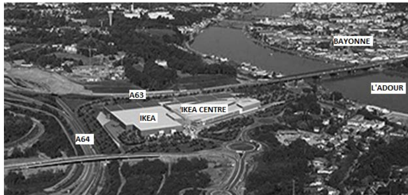
Figure 1. Vue générale des deux projets
