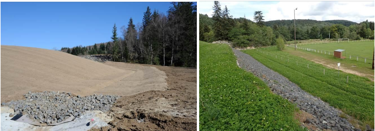
Figure 7. Dôme et fossé en mars 2014 (géomembrane, toile de jute, ...).
