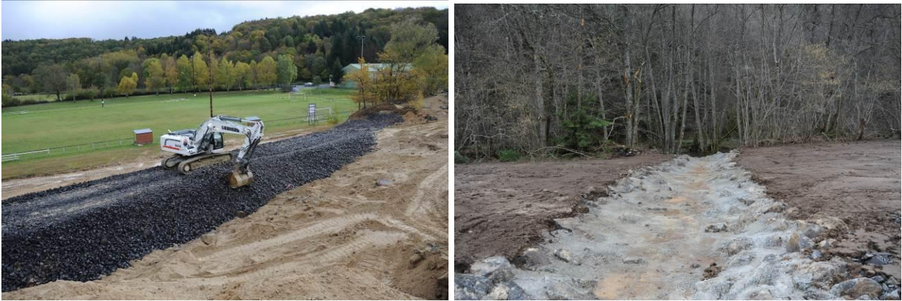
Figure 5. Remodelage (merlon en scories) côté stade.
