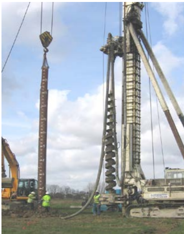
Figure 1. Installation de pieux battus et forés sur le site de Merville
