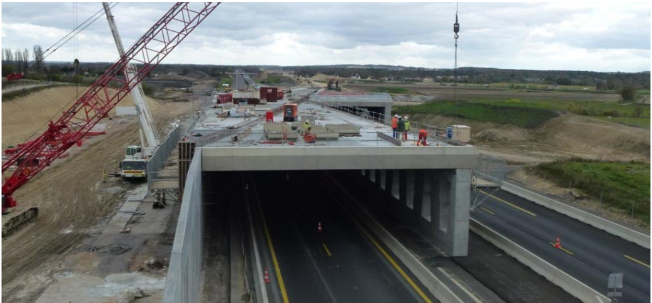
Figure 2. Ouvrage en construction
