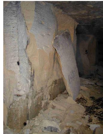
Figure 4c : Écaillage important d'un pilier d'une carrière de calcaire grossier
