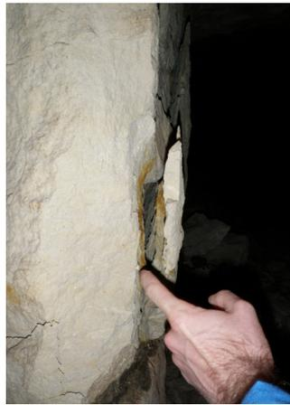
Figure 4b : Petit écaillage d'un pilier
