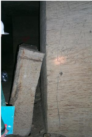
Figure 4a : Fissure mécanique dans un pilier d'une carrière de calcaire grossier
