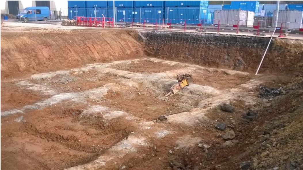
Figure 4: Dégarnissage d'un caisson de jet grouting.
